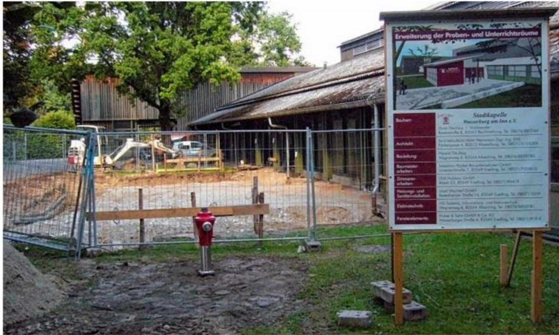
Die Bauarbeiten zur Erweiterung des Probenheimes der Stadtkapelle haben begonnen.
